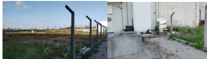
Figura 2: Área externa do prédio, em fase de construção; acúmulo de entulhos na área externa do prédio.
