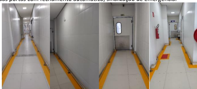
Figura 5: Corredores de acesso à produção, paredes de cerâmica, estrutura das portas com fechamento automático, sinalização de emergência.
